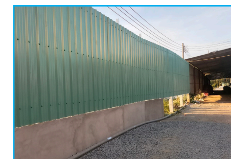
TƯỜNG BAO NHÀ MÁY
